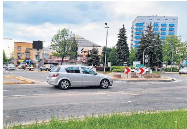
Przez ponad rok w tym miejscu Tarnowa trwać ma budowa ronda oraz przejścia podziemnego
