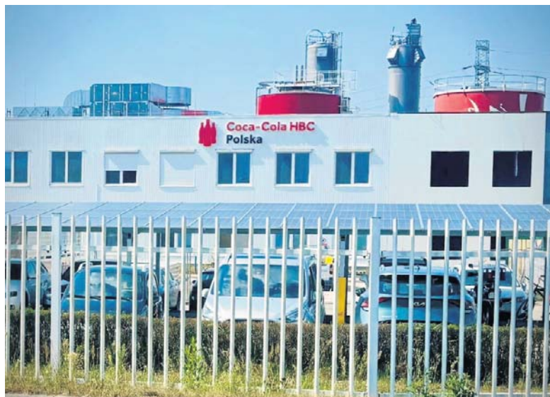
Coca-Cola HBC Polska chce rozbudować zakład pod Krakowem
