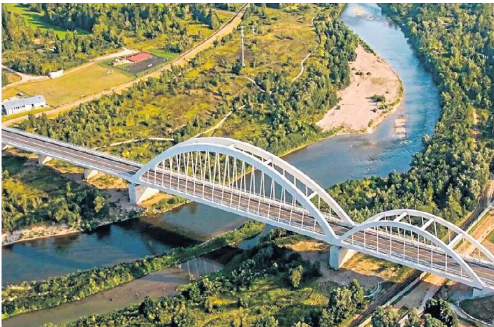
Budowa trzeciego mostu na Dunajcu może ruszyć po oddaleniu odwołania przez KIO
