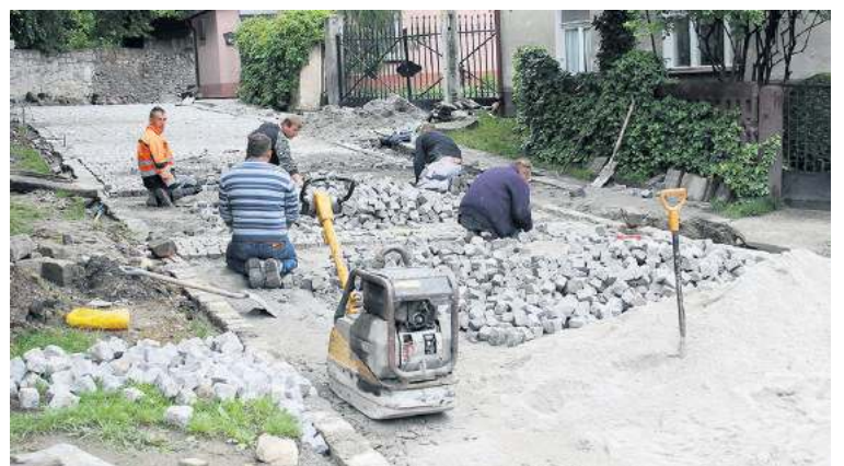
W ubiegłym tygodniu pracownicy kładli nawierzchnię z kostki
