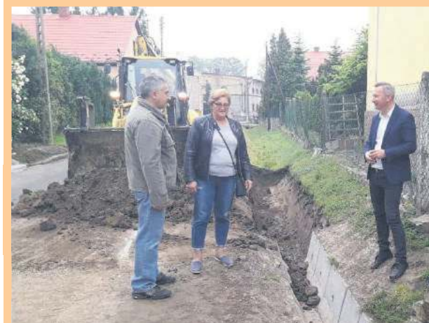
Wójt Kondratowic Tomasz Gracz (z prawej) obserwuje prace związane z odbudową rowu melioracyjnego w Lipowej. Obok radna Teresa Białkowska i sołtys Lipowej Roman Pierożek (Foto: UG Kondratowice)
