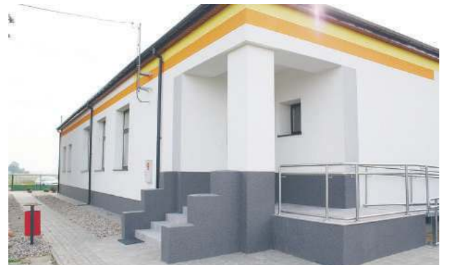
Termomodernizacja i OZE w Przedszkolu w Stężycy Kolonii (2019)
