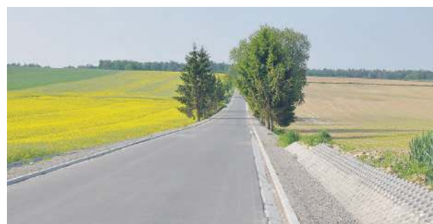
Droga Niemienice - Kol. Niemienice - Jaślików (2023)
