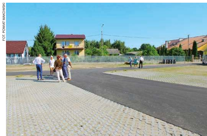
Obiekt zyskał m.in. nowe nawierzchnie
