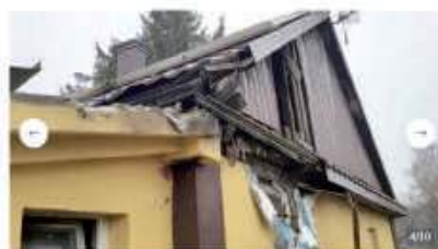
Dwa lata temu 40-letni, drewniany dom został przez rodzinę gruntownie wyremontowany. Docieplono ściany, wymieniono dach, zainstalowano kolektory słoneczne. Wszystko to strawił ogień. Można pomóc rodzinie, otwierając link: https://zrzutka.pl/ucdxep (hasło: Na pomoc w odbudowie domu po pożarze)
