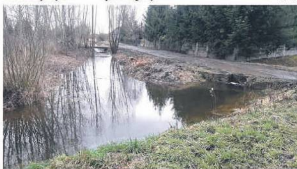
Poniemiecki przepust wypełniony
