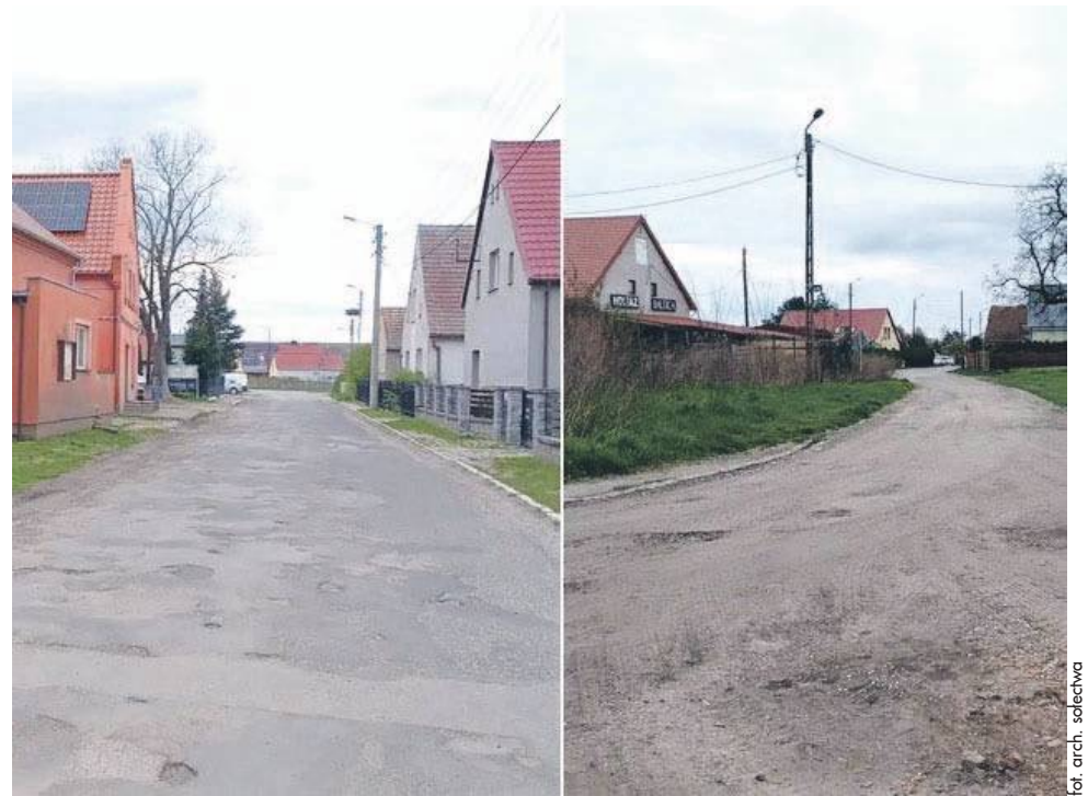
Chodzi o remont tej drogi
