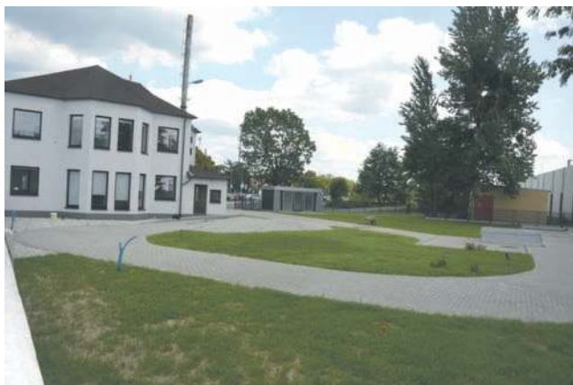
Plac manewrowy jest już prawie gotowy
