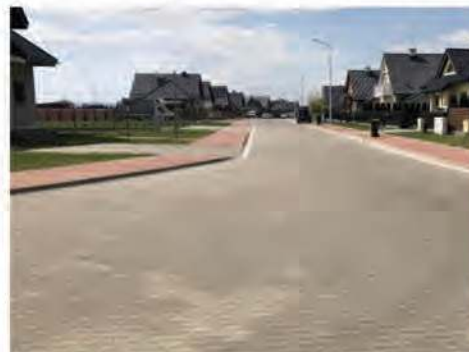
Mieszkańcy ulicy Jaśminowej czekali kilkanaście lat na budowę drogi.
