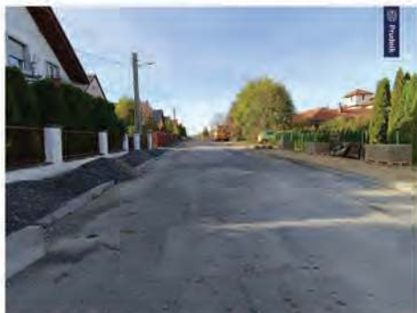
Ulica Wybickiego w trakcie remontu.
