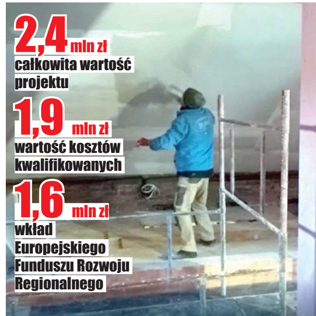
Prace na poddaszu. Gipsowanie ścian
