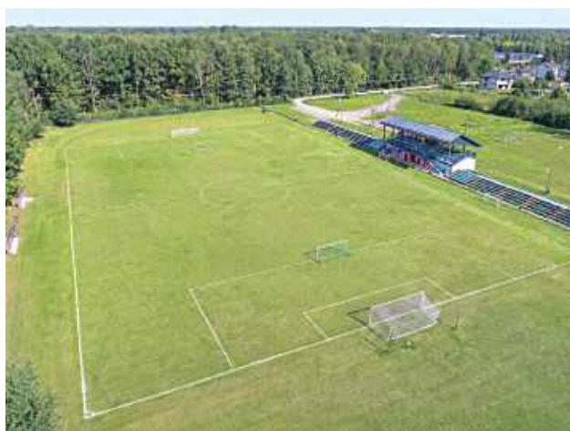
Stadion Miejski przy ul. Spacerowej w Pilawie czeka gruntowna przebudowa najważniejszej części sportowego obiektu
