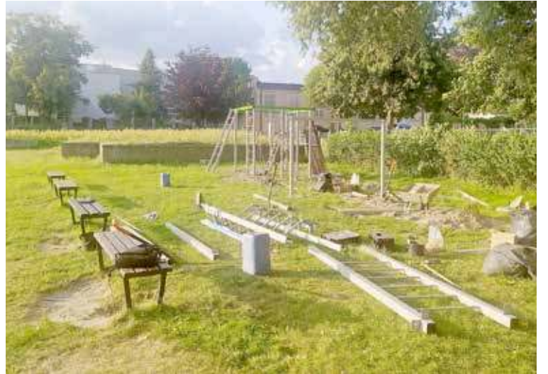
Od początku bieżącego tygodnia trwa montaż urządzeń na plaży miejskiej
