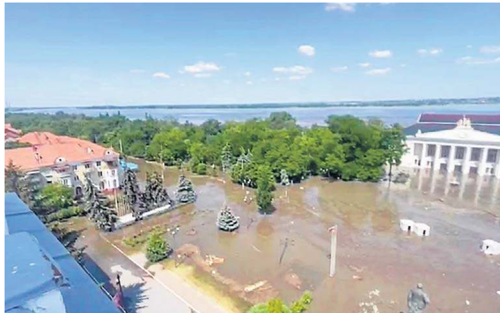
Spadający poziom wody w zbiorniku kachowskim zagraża również Krymowi. Półwysep, który znajduje się pod kontrolą Rosji, jest gorący i suchy
