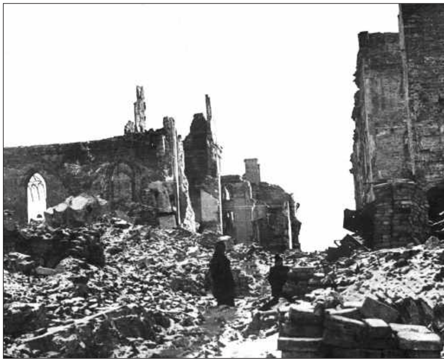
Zrujnowane budynki przy ul. Świętojańskiej na Starym Mieście. Z lewej widoczne ruiny katedry św. Jana.
