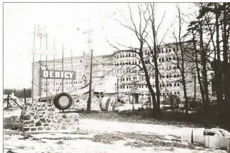
Rok 1974. Szpital w budowie.
