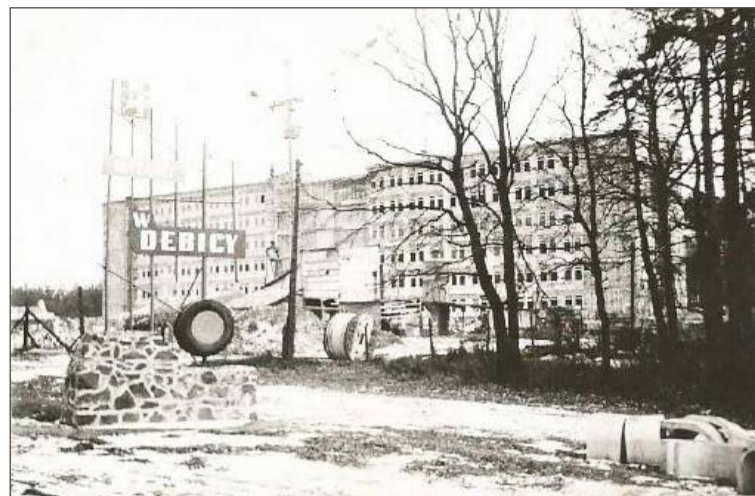
Rok 1974. Szpital w budowie.
