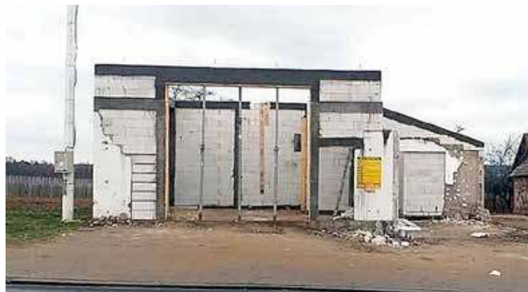
Na razie stoją ściany bez dachu.
