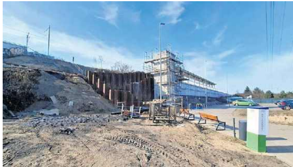
Na linii kolejowej nr 406 powstają nowe perony
