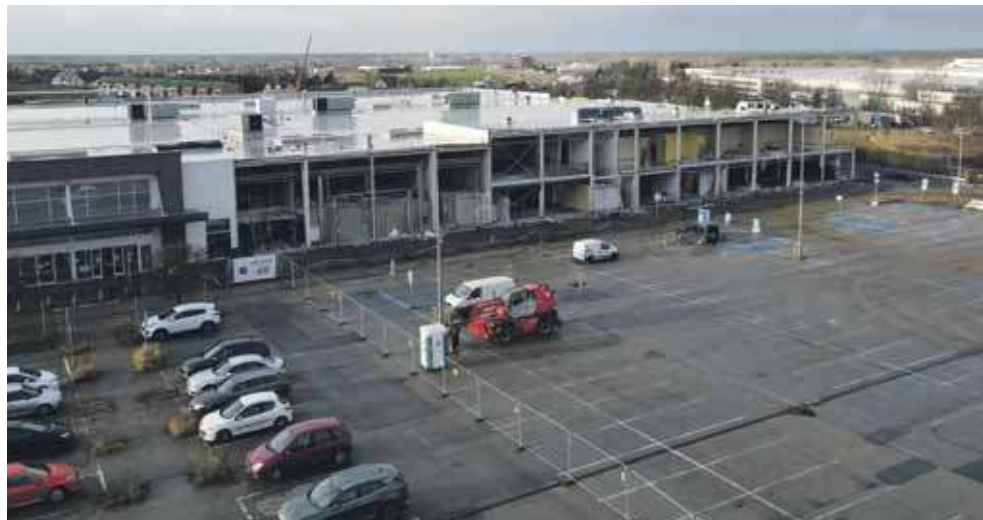
Powoli znika przednia ściana dawnego Tesco
