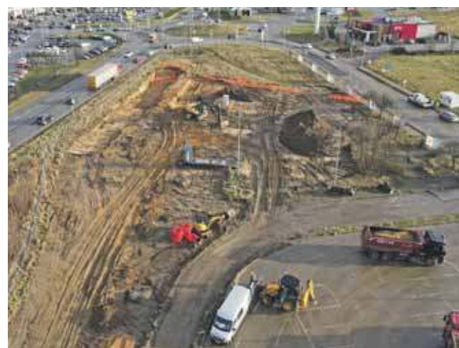
W rejonie ronda trwają roboty ziemne
