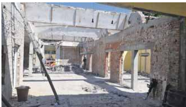
Prace rozpoczęto od wyburzeń. Tak było ponad rok temu
