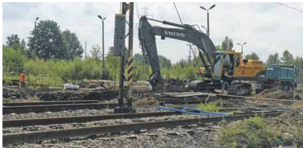
Urząd miejski zapewnia, że prace przy budowie tunelu nie utrudnią życia pieszym i kierowcom
