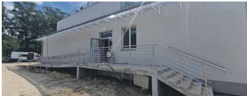
Blok operacyjny powstaje w miejscu, w którym kiedyś znajdowała się kuchnia szpitalna
