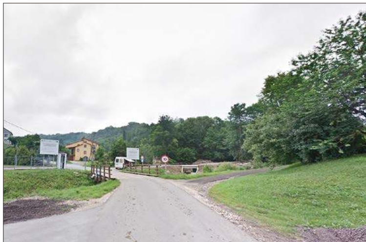
Przebudowana ma być również zatoka autobusowa.
