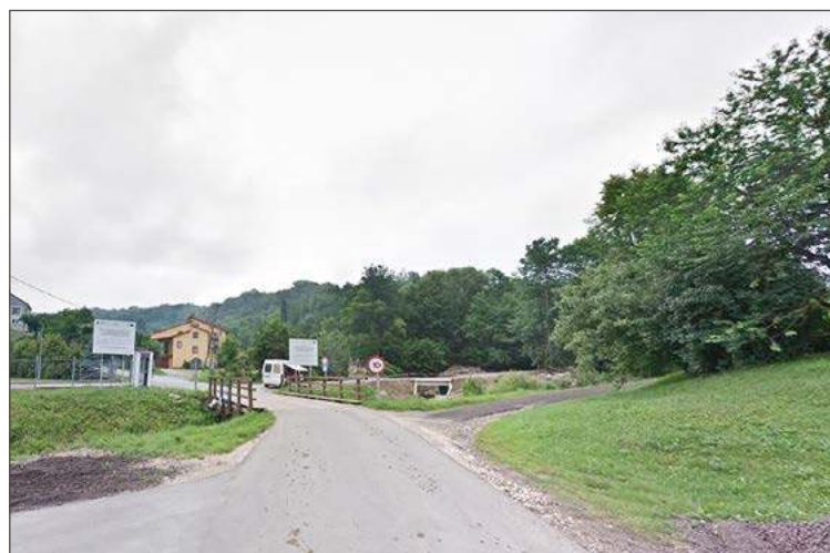
Przebudowana ma być również zatoka autobusowa.
