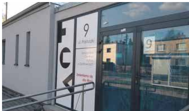
Filia w Opatowicach przechodzi gruntowny remont
