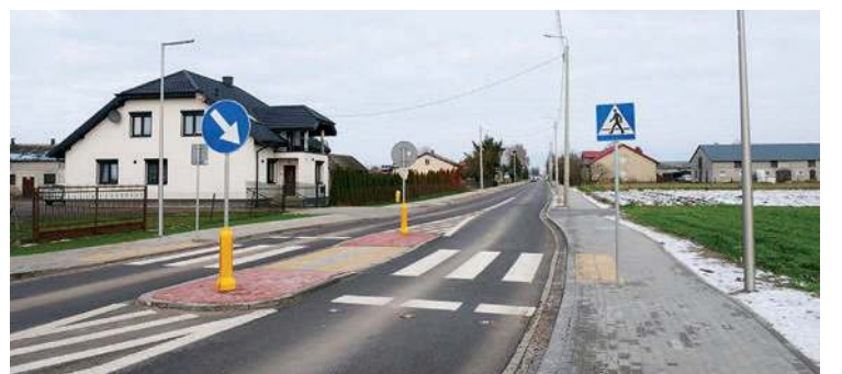
Tak wygląda wjazd do Dozin po przebudowie
