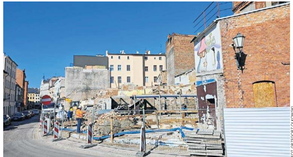
Tak postępują prace w Starym Browarze na starówce w Toruniu. Powstaje tutaj luksusowy hotel. Zdjęcie z piątku, 6 marca
