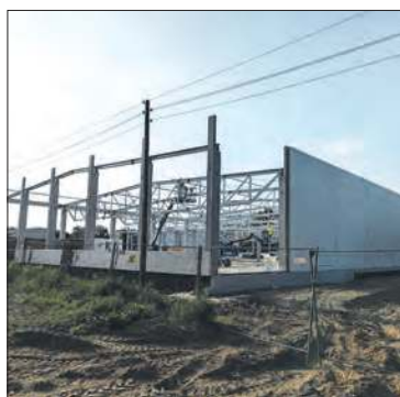
Aktualny stan budowy jednego ze sklepów
