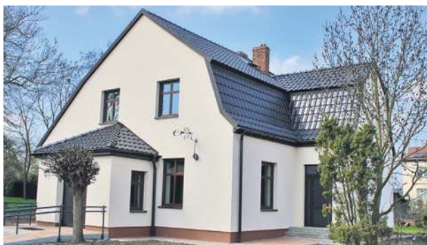
W Bukowcu przeprowadzono kompleksowe odnowienie budynku organistówki
