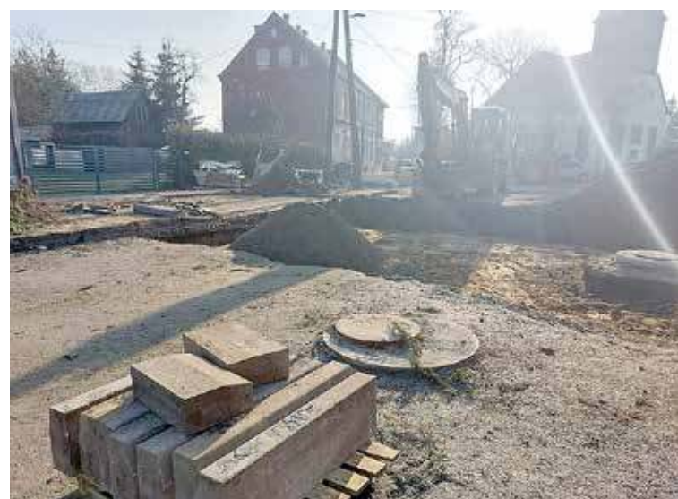
Układanie warstwy stabilizacyjnej na jezdni nieco się opóźniło ze względu na niską temperaturę powietrza. Fot. ZZDW
