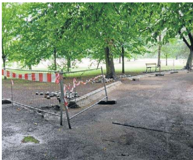
Alejki w części angielskiej parku wymagają remontu
