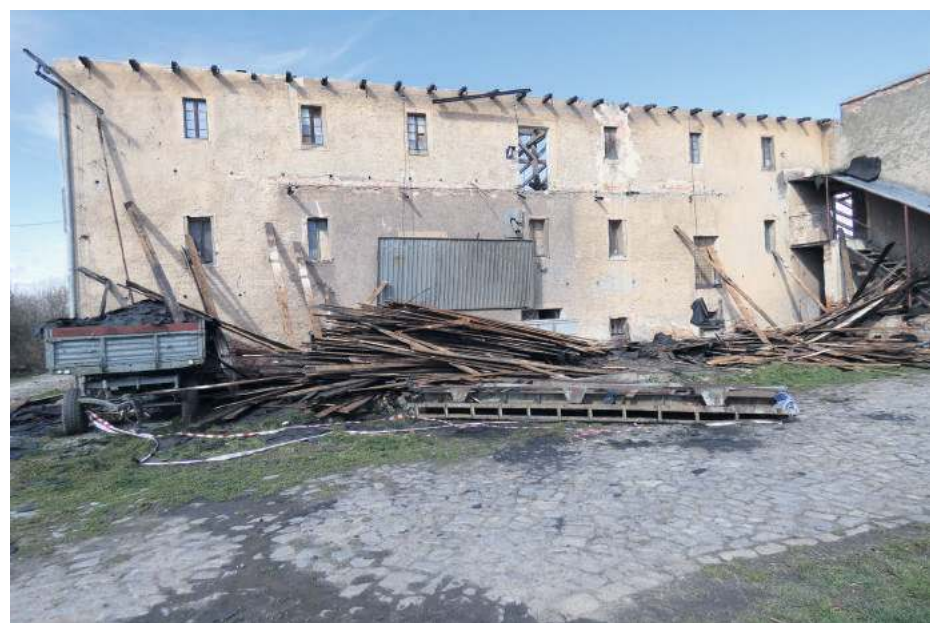
Od kilku dni trwa rozbiórka byłych magazynów zbożowych
