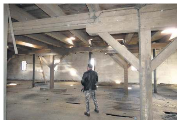
Jacek Dębiński zwrócił uwagę na dobry stan części konstrukcji drewnianej
