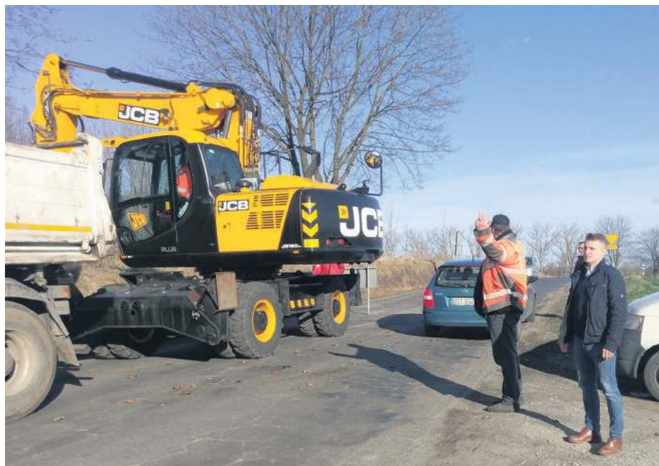
Na odcinku Strzelin-Jegłowa ruszyła przebudowa nawierzchni. Pracę dogląda dyrektor PZD w Strzelinie Zdzisław Ziąber (z prawej)
