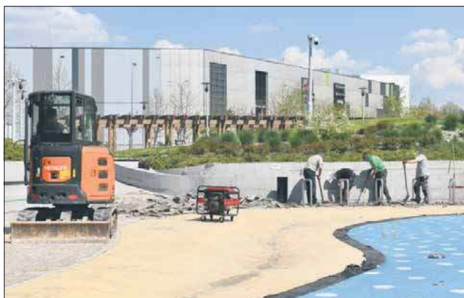
Prace remontowe już trwają
