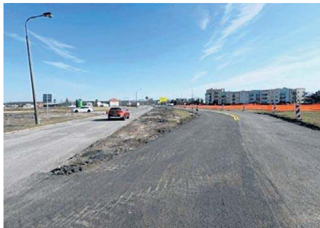
Organizacja ruchu na ulicy Podmiejskiej na kolejnych etapach inwestycji może się zmieniać
