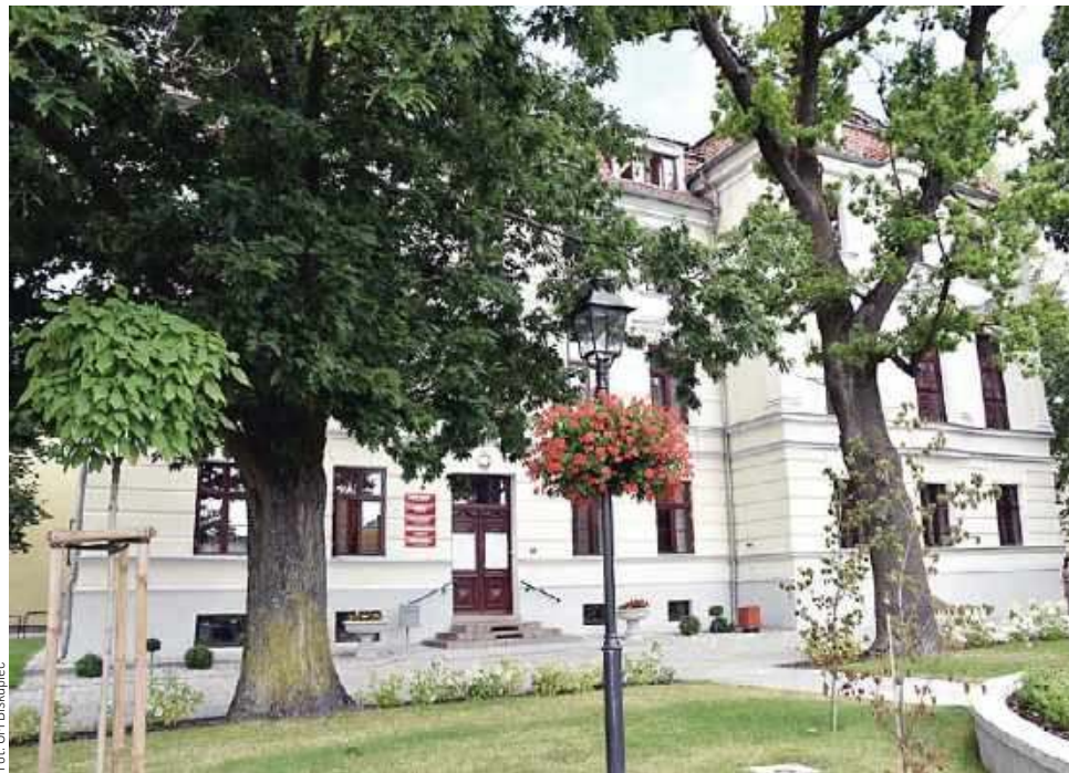
Na zrewitalizowanym terenie wokół Urzędu Miejskiego w Biskupcu zostały zamontowane energooszczędne lampy ledowe
