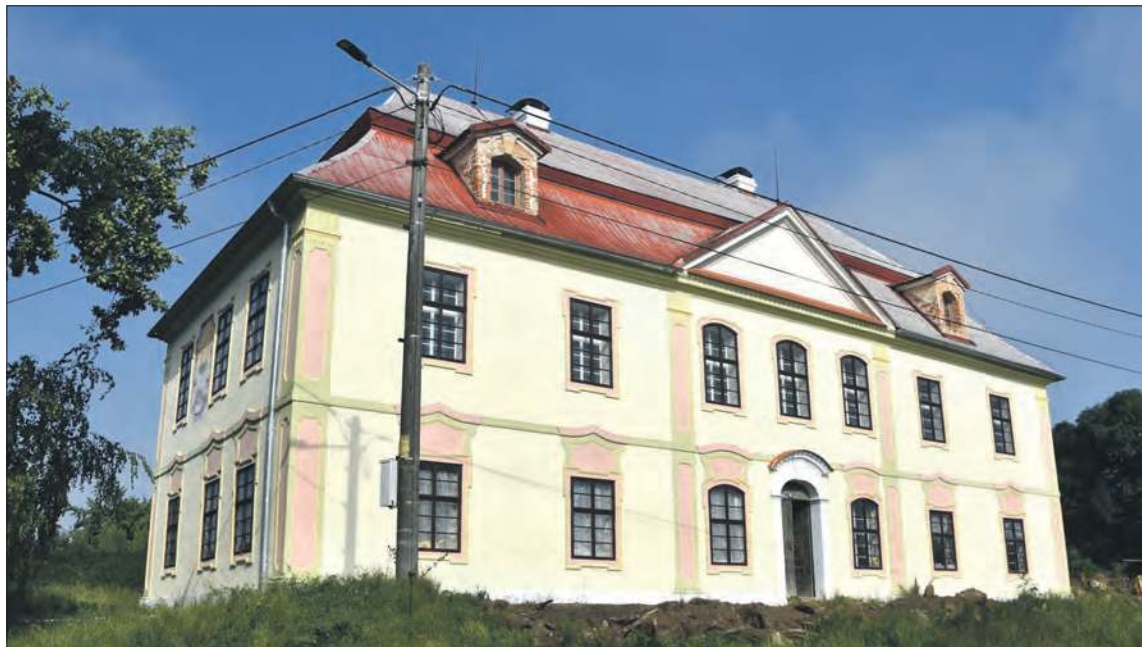
W 2021 roku odnowiono elewację barokowego dworku
