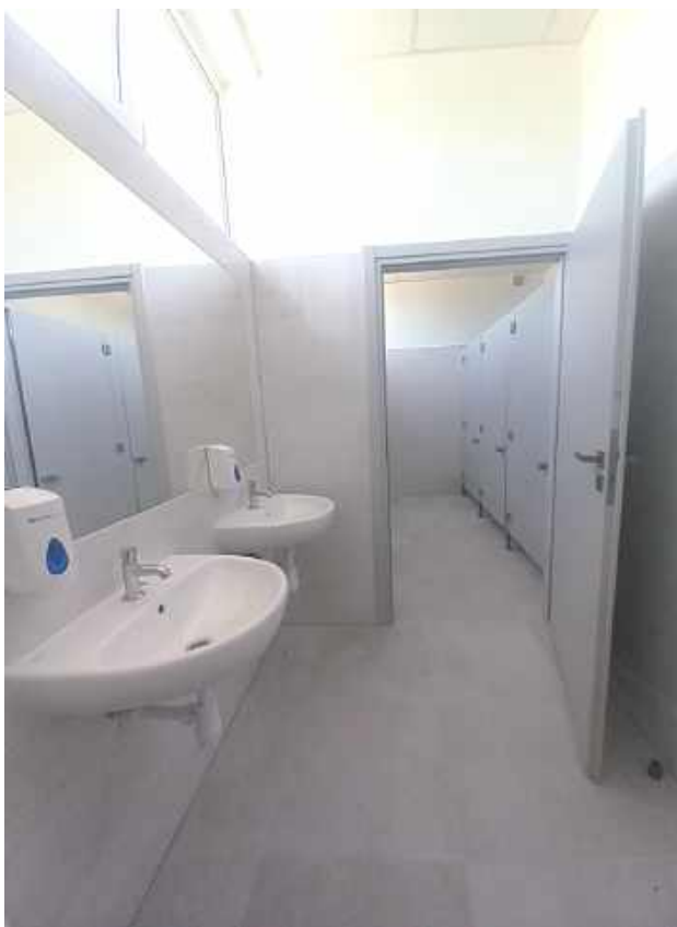
Remont przeszły między innymi łazienki szkolne
