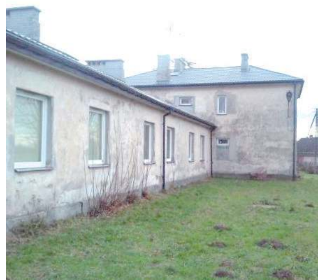
Budynek świetlicy wybudowano w latach sześćdziesiątych. Tu mieściła się szkoła podstawowa. Gdy podstawówkę zlikwidowano budynek stał się miejscem spotkań lokalnej społeczności
