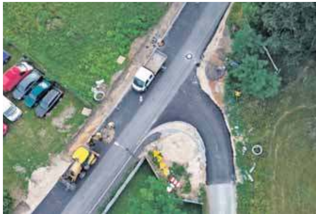
Na budowie widać postępy prac
