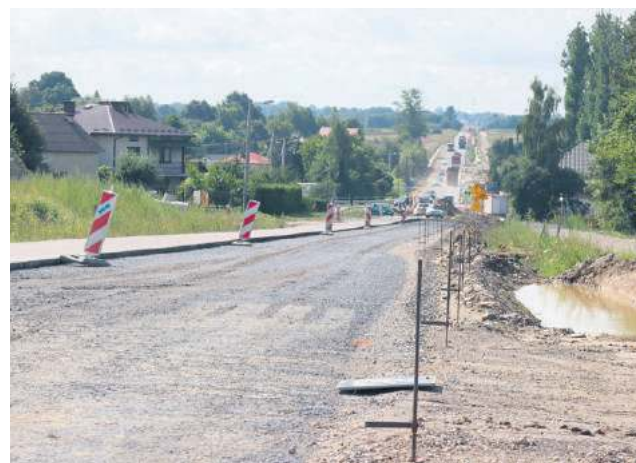
Obecnie trwa przebudowa drogi wojewódzkiej nr 835 z Biłgoraja – przez Tarnogród – do granicy województwa.
