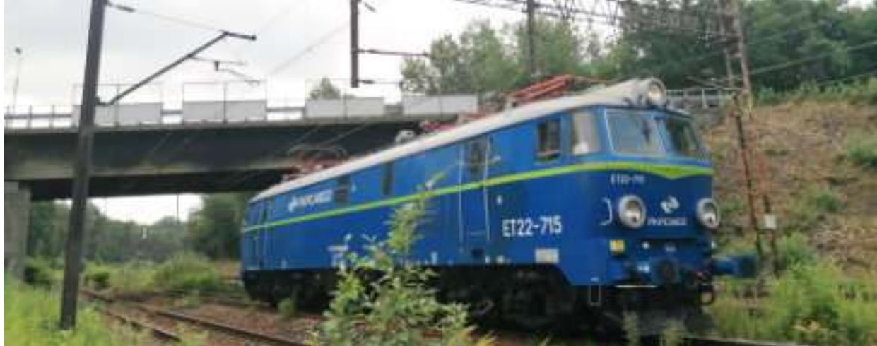
► Wiadukt nad torami kolejowymi w ciągu ul. Roosevelta Fot. Igor Cieślcki
