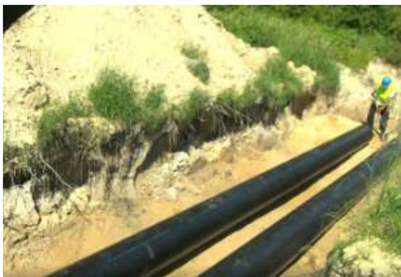
► W ramach inwestycji powstaje około 10 km nowej sieci Fot. TVZ
