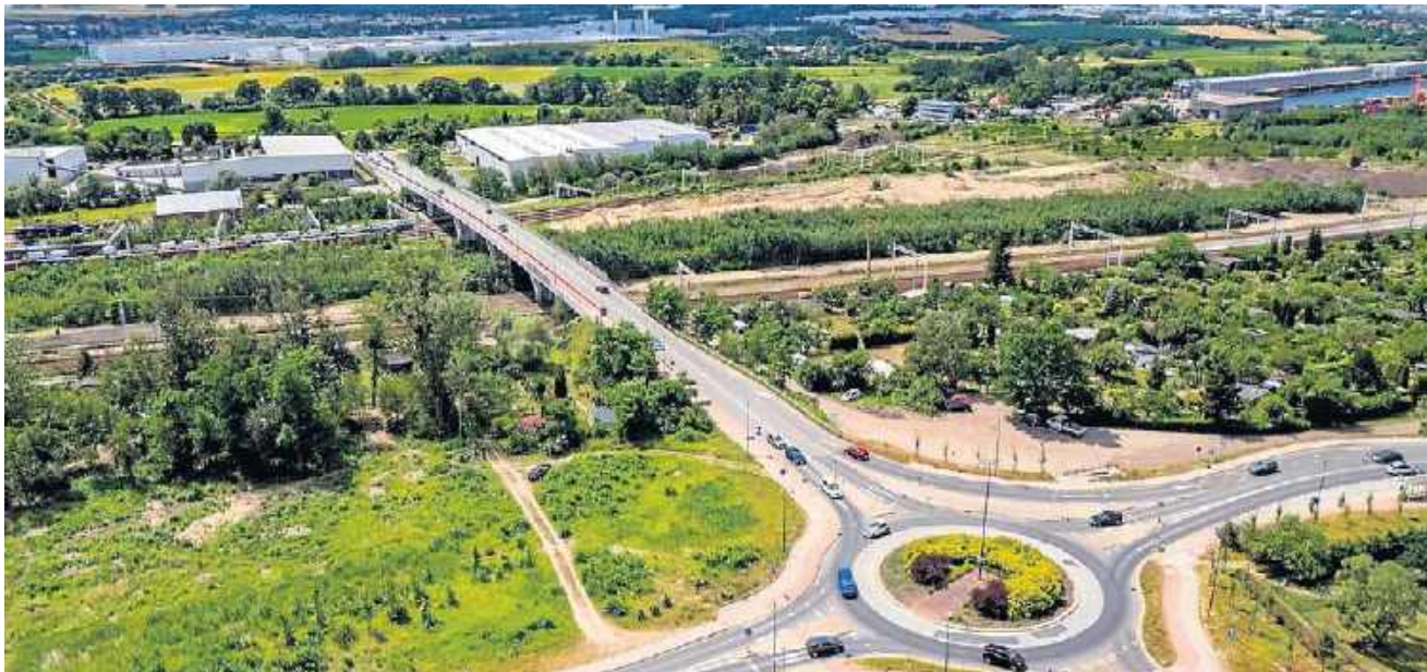
Budowa węzła przesiadkowego Gliwice – Kopernik coraz bliżej. Powstanie w tym rejonie, w sąsiedztwie estakady
