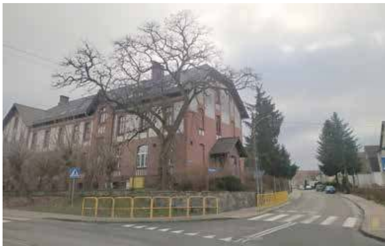
Jedną z inwestycji to termomodernizacja budynku filii DPS mieszczącej się przy ul. Piłsudskiego w Nowogardzie
