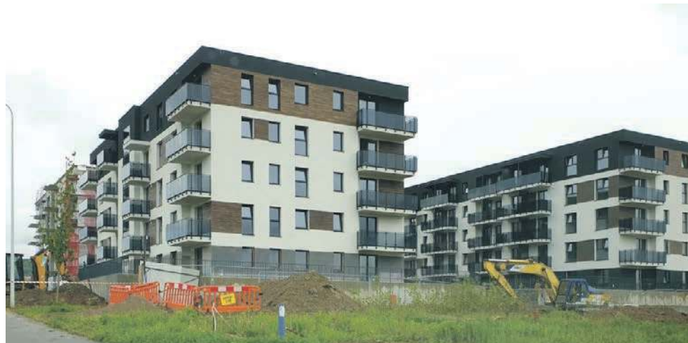
Nowe osiedle powstaje w Krzeszowicach
