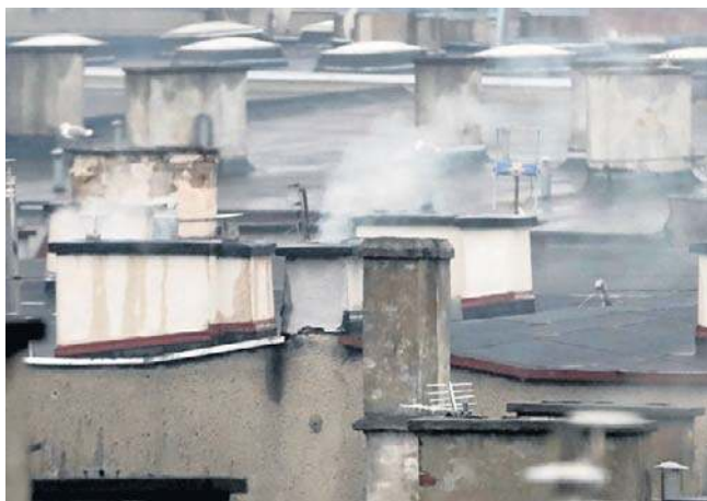
Strażnicy kontrolują jakość powietrza. Czasami wchodzą do mieszkania i sprawdzają pochodzenie opał.
