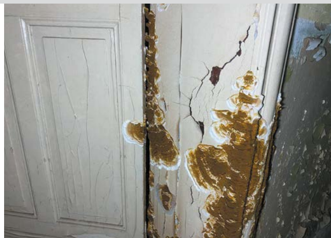
FOT. 3 Owocniki na elemencie drewnianym (ościeżnica); fot.: autor
