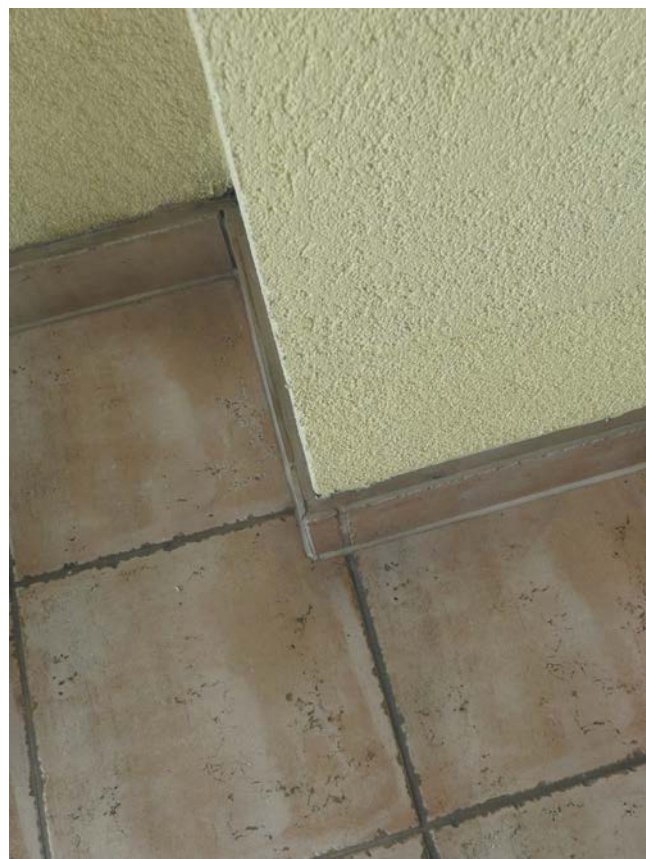
FOT. 2 Wyjątkowo niekorzystny sposób wykonania cokolika. Opis w tekście; fot.: autor
