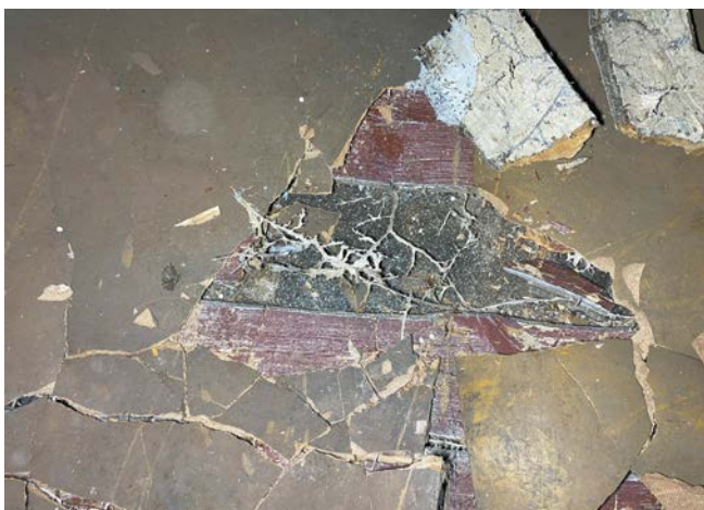
FOT. 8 Sznury grzybniove pod drewnianą podłogą; fot.: autor
