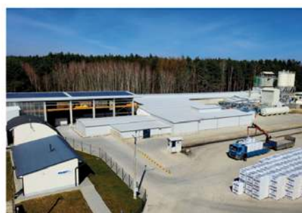
ZAKŁAD BETONÓW W LIPIU
