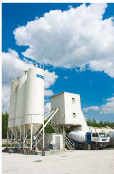
ZAKŁAD BETONÓW W LIPIU - WĘZEŁ BETONIARSKI
