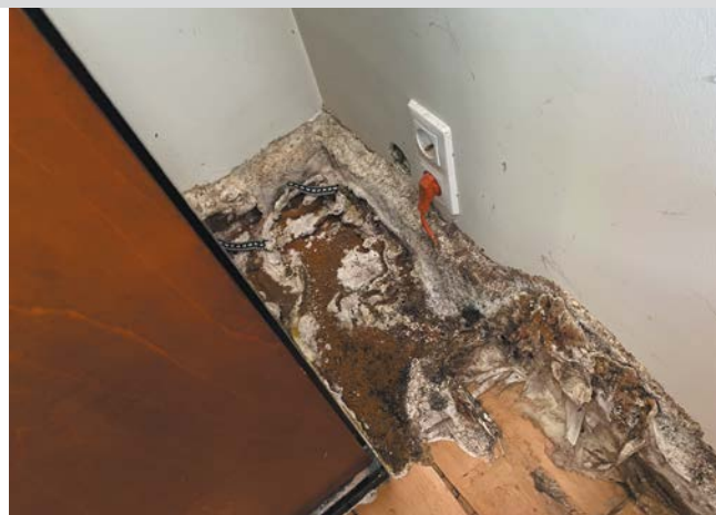
FOT. 10 Zdeformowany owocnik w miejscu, w którym grzyb przerósł przez ścianę; fot.: autor
