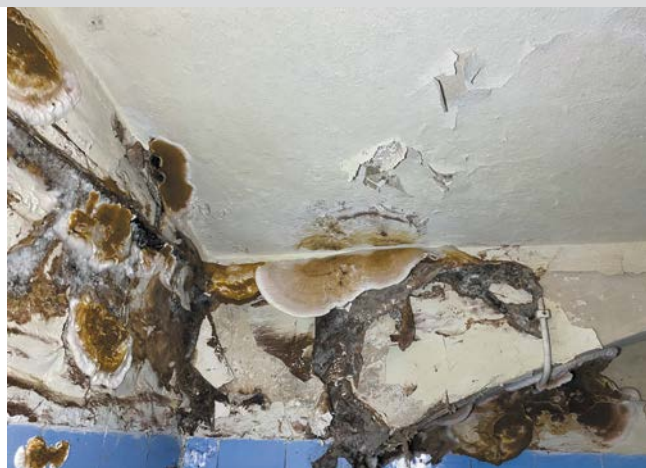
FOT. 1 Owocniki strocza domowego na podłożu mineralnym; fot.: autor
