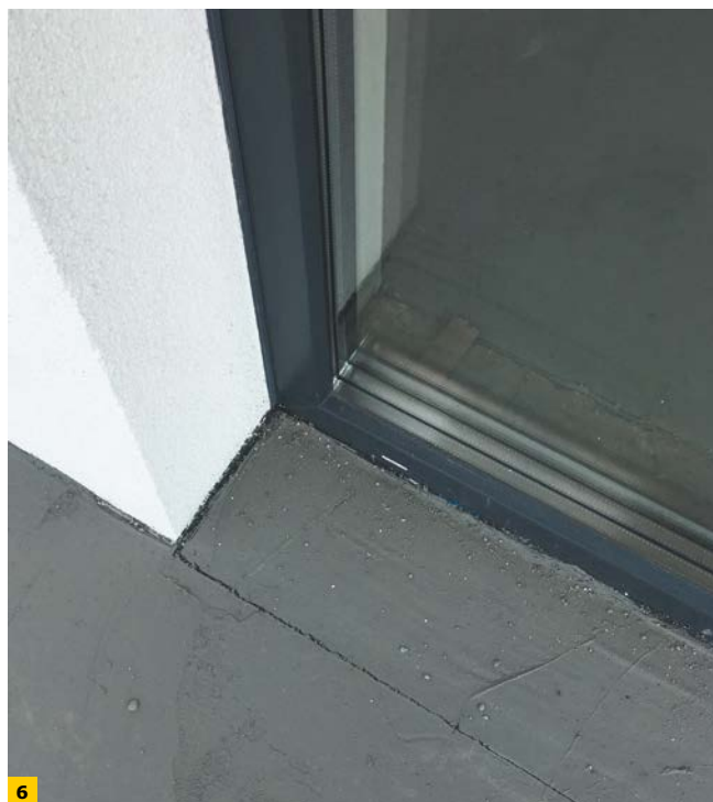
FOT. 5–6 Rysa w hydroizolacji na styku łącznika izotermicznego z płytą. Opis w tekście. Zdjęcie pokazuje także sytuację, do której odnosi się FOT. 2 oraz RYS. 5; fot.: autor
