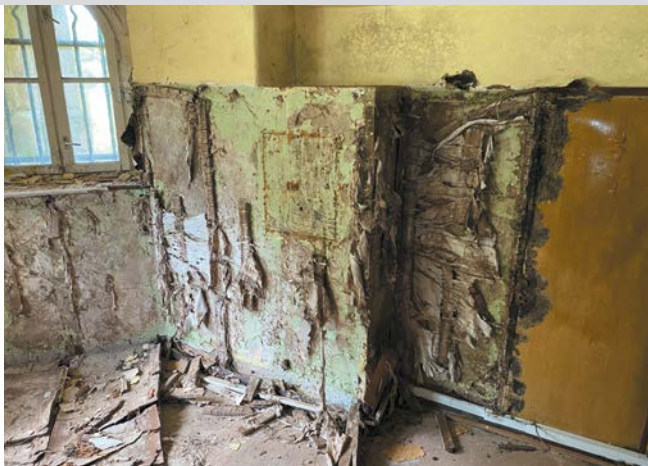
FOT. 6 Typowa grzybnia powierzchniowa ma kolor od brudnoszarego do srebrnoszarego; fot.: autor
