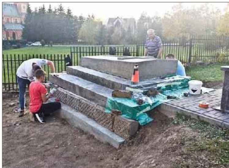
Dzięki kwestom wyremontowany został nagrobek Klemensa Rutowskiego.
