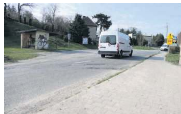
Wszystko wskazuje na to, że niebawem ruszy remont drogi w Nieszkowicach
