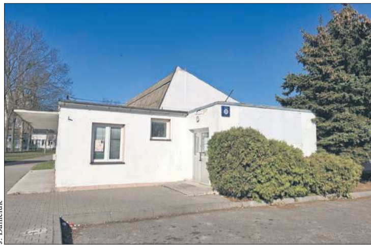
Pływalnia „Kobyłanka” została zamknięta w maju ubiegłego roku. W jej miejsce powstaną parkingi
