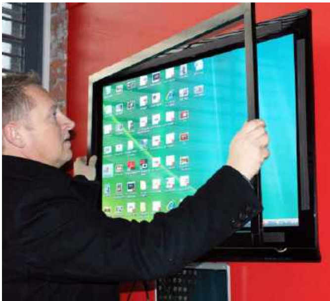
Fotografia 10. Montaż kurtyny IR do istniejącego ekranu ( https://t.ly/JWx3z )
