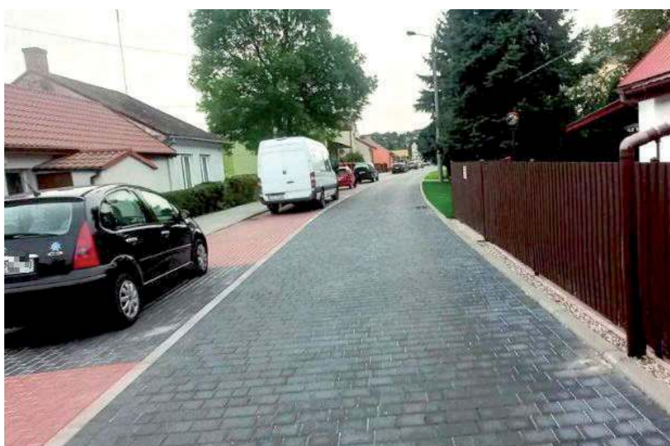
Prace były prowadzone m.in. na ul. Nadwalnej
