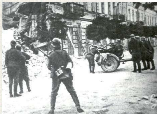
Zniszczona w bombardowaniu we wrześniu 1939 kamienica przy ulicy Piłsudskiego 4 w Łukowie. W jej piwnicy zginęło około 40 osób, w dużej części uciekinierów z innych miast
