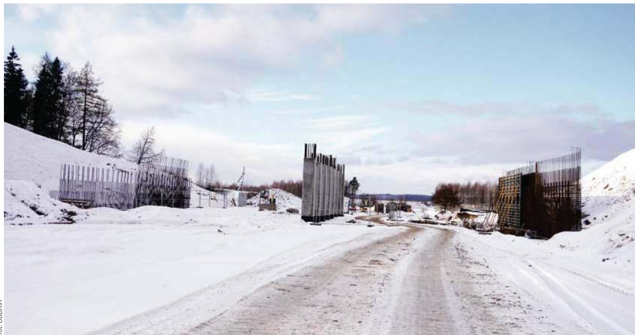
Obecnie trwa budowa nowej S16 na odcinku Borki - Mrągowo
