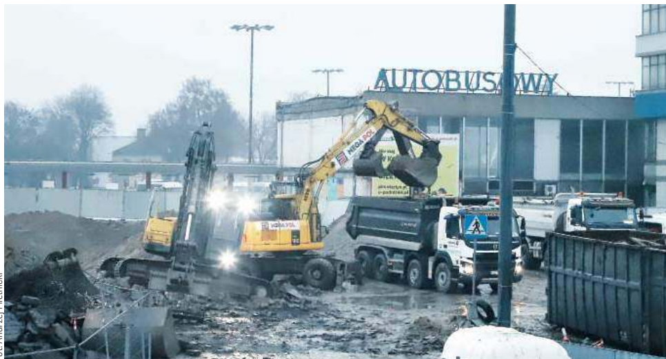
Rozbiórka dworca PKP już się kończy
