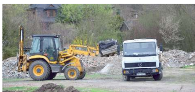
Zgodnie z zapowiedziami burmistrza teren po szkole kontenerowej zostanie uprzątnięty, a betonowe płyty z tego miejsca zostaną przeznaczone na umocnienie jednej z dróg w sołectwie Doły-Wylągi
