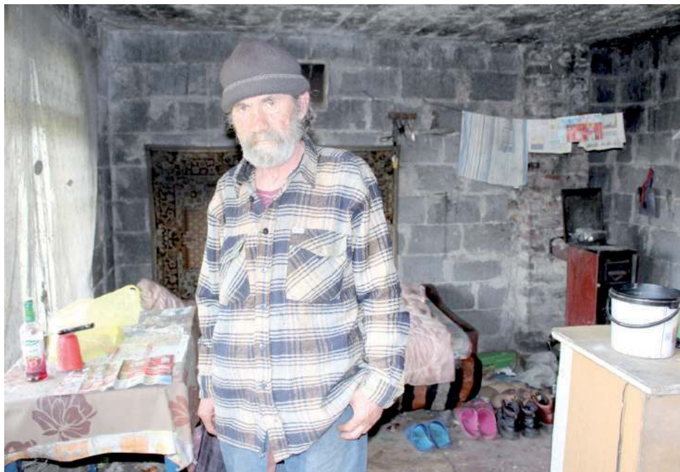
Warunki w jakich mieszka pan Andrzej są skandaliczne. Grzyb i wilgoć na ścianach nieocieplonego budynku zagrażają jego zdrowiu
