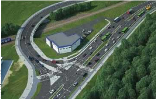
Przymiarki do budowy ulicy Nowobałtyckiej trwają od lat
